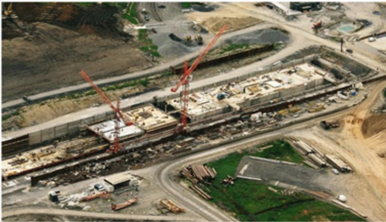
Figura 3 - Construção dos elementos em doca seca
