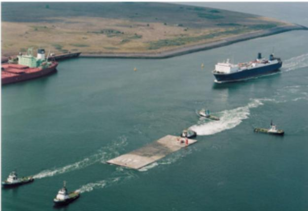
Figura 5 - Transporte dos Elementos
